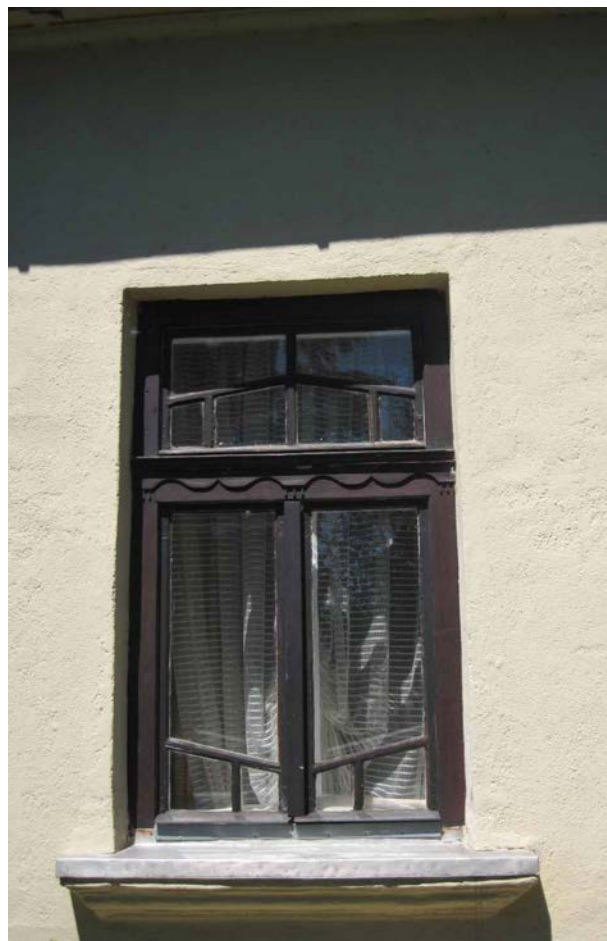
Megőrzött, felújított régi ablakszerkezet tagozatos párkánnyal
